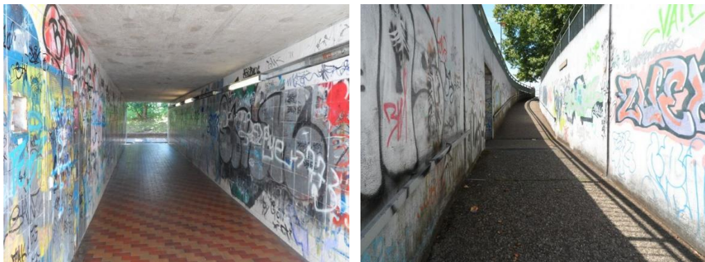
Abb. 19: Unterführungen im Bereich der Bundesstraßen
