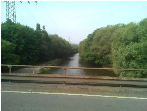
Abb. 1: Gewässer Prims, Blick von Brücke über DH-Wehr, geplante Einleitstelle links im Bereich Anlandung; Blick in Fließrichtung
