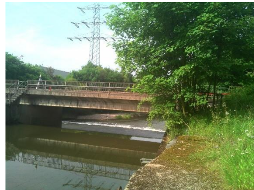
Abb. 2: Gewässer Prims, Blick unter Brücke über rechtes Wehrfeld, geplante Einleitstelle im Hintergrund im Bereich Anlandung; Blick in Fließrichtung
