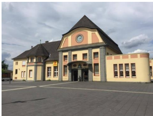
Abb. 20: Bahnhof und Bahnhofsvorplatz
