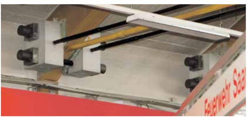
**MIT DEN GELBEN SPANNSEILEN WURDE DIE GEWÖLBTE DECKE DES GERÄTEHAUSES ABGESpanNT. DOCH WEIL KORROSION DAS INNENLEBEN DER SEILE BESCHÄDIGTE, MUSSTE DIE ALTE KONSTRUKTION VERSTÄRKT WERDEN.**
