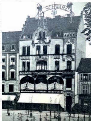
Das ehemalige Geschäftshaus am Großen Markt 17
